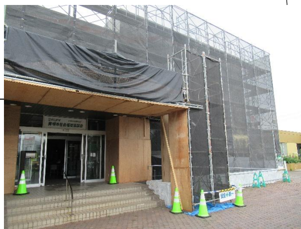
修繕工事中の総合福祉センター（7/31 現）
