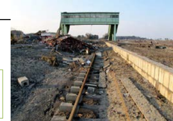
震災直後の 新地駅跨線橋
